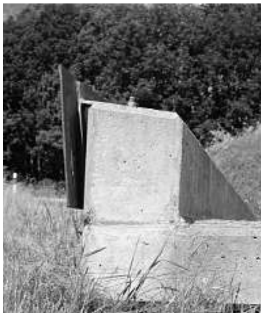
Piastra d'acciaio montata sullo spigolo superiore della parete anteriore del rifugio dei marcatori
