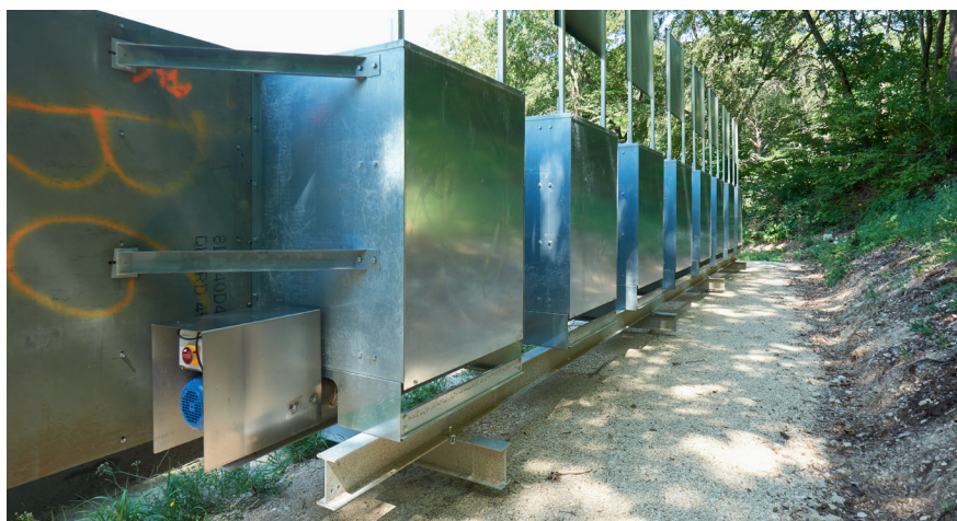
Fig. 53: Vista posteriore del sistema di parapalle, variante Berin con sistema di evacuazione
