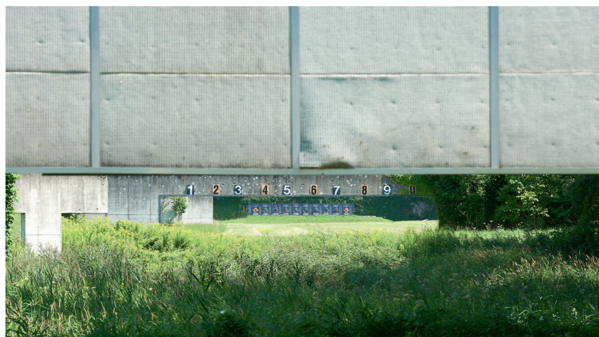
Fig. 57: Paratia laterale e d'altezza in cemento armato
