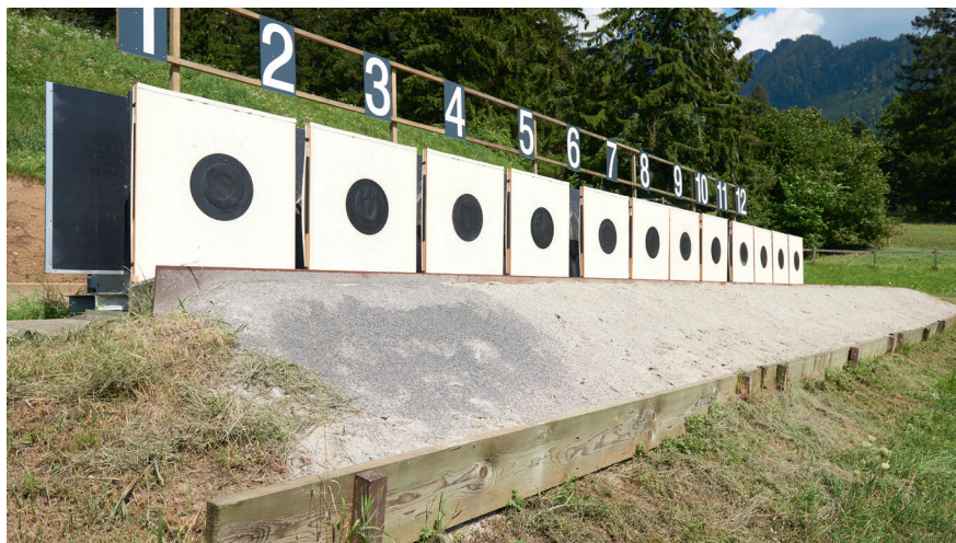
Fig. 40: Pre-parapalle in sabbia con piastra d'acciaio montata
