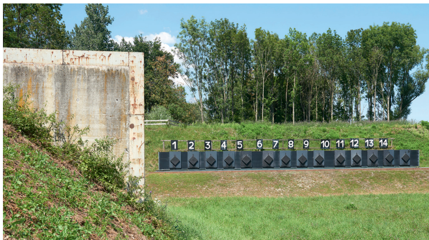
Fig. 58: Paratia laterale in cemento armato
