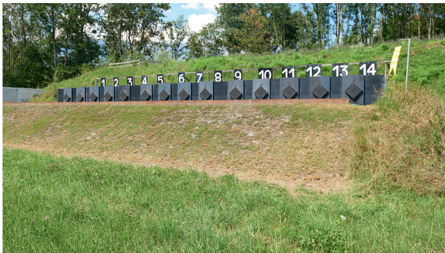
Fig. 39: Pre-parapalle in terra con piastra d'acciaio montata
