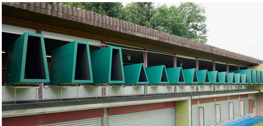
Fig. 23: Tunnel fonoassorbente (triangolare)
