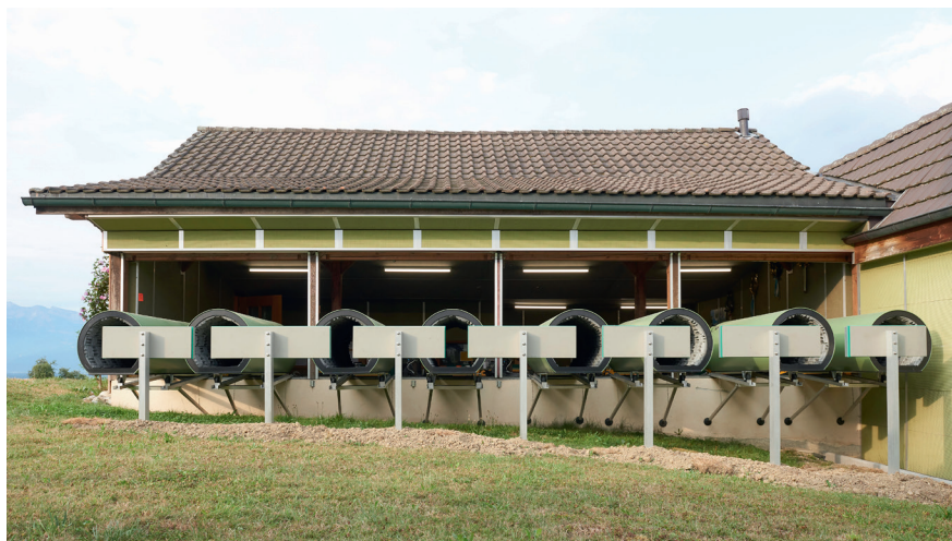
Fig. 64: Paratia laterale di prossimità per il tiro a terra con tunnel (vista dall'esterno)
