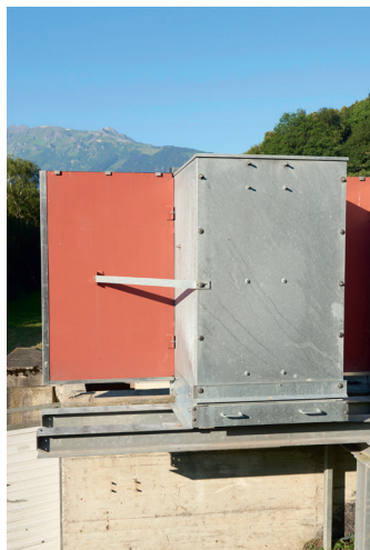
Fig. 51: Vista posteriore del sistema di parapalle, variante L+H con cassetto
