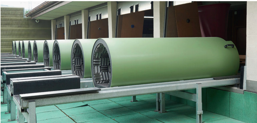
Fig. 22: Tunnel fonoassorbente (circolare)
